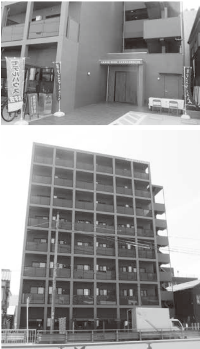
エントランス(上)と全景
